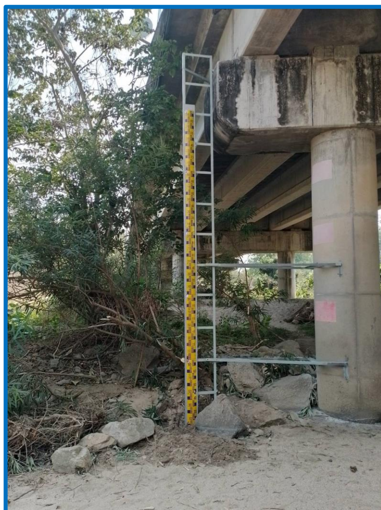
รูปที่ 10 ติดตั้งแผ่นวัดระดับน้ำ (Staff Gauge) สถานี ห้วยแม่ป่าไผ่ สะพานบ้านตีนตก ต.นาคอเรือ อ.ฮอด จ.เชียงใหม่ (ทำโครงการอ่างเก็บน้ำห้วยแม่ป่าไผ่ อันเนื่องมาจากพระราชดำริ จังหวัดเชียงใหม่)
